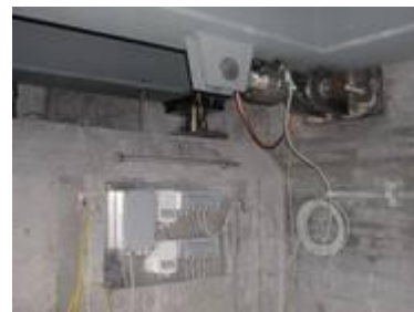
Fot. Przetworniki wagi i siły zainstalowane w wadze
